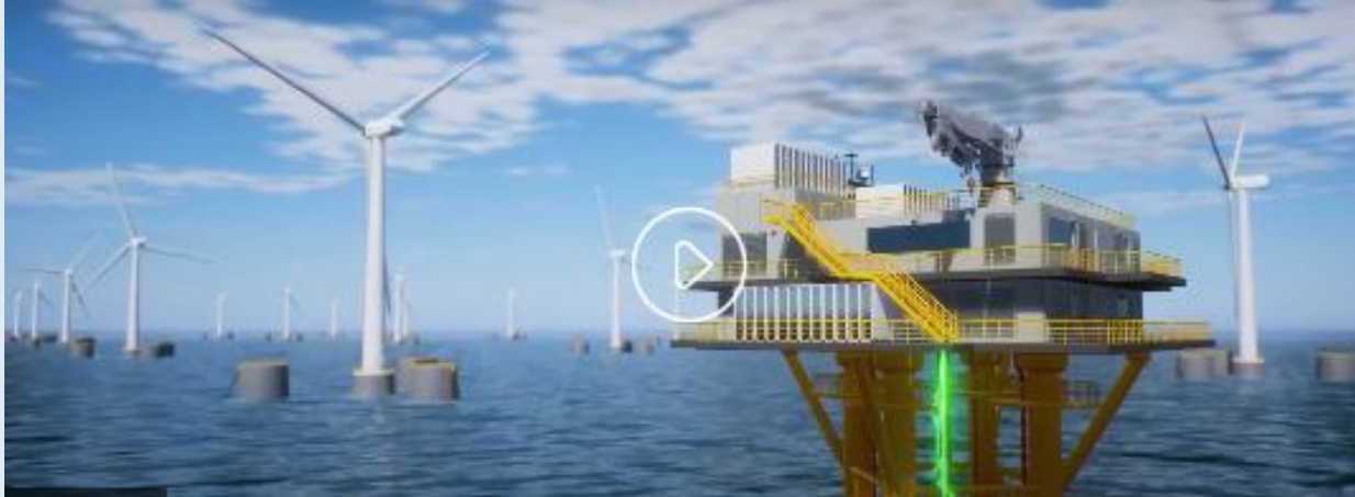
Subestació elèctrica flotant
